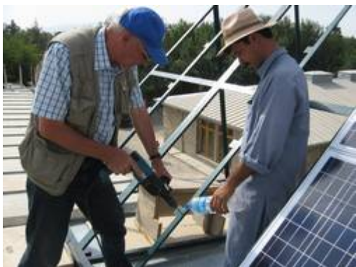
Montage der Solaranlage durch Hannsgeorg Preuß und seinen afghanischen Kollegen auf dem Dach des Teacher-Training-Colleges in Taloqan, Afghanistan
