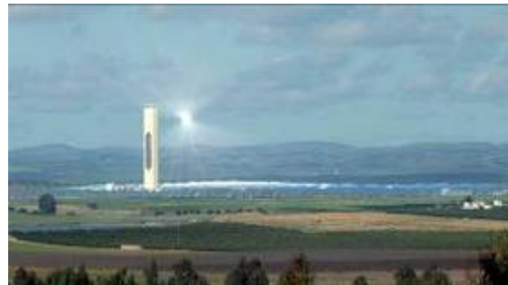
Planta Solar 10 MW, Sevilla
