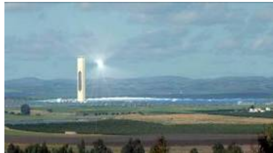
Planta Solar 10 MW, Sevilla
